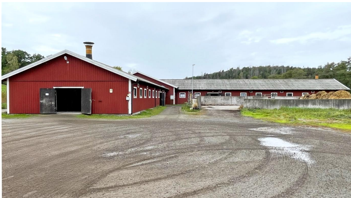
1. Stall med gödselplatta.
