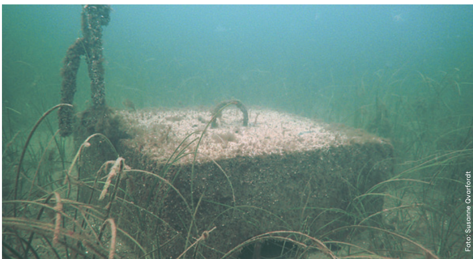
Ålgräsgräs runt en bojsten där en pålboj förankrats med lina. Pålbojen gör att linan inte slackar vilket minimerar skador på omgivande vegetation, samt även vegetation på bojstenen.
