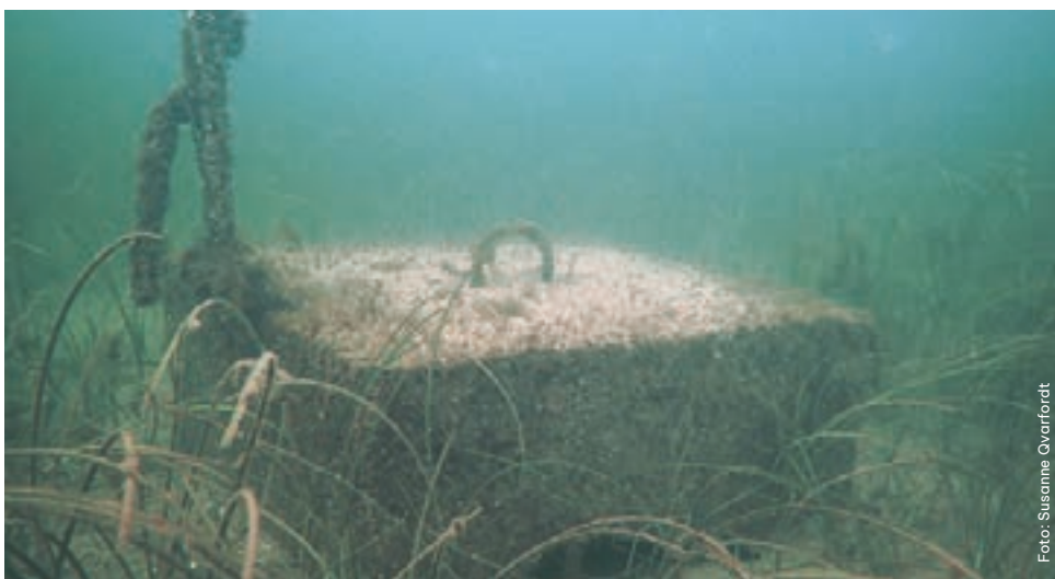
Ålgräs runt en bojsten där en pålboj förankrats med lina. Pålbojen gör att linan inte slackar vilket minimerar skador på omgivande vegetation, samt även vegetation på bojstenen.
