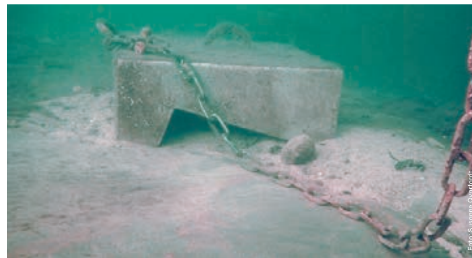
Kring bojstenar med kätting vars längd anpassats till att klara vattenståndsförändringar är det inte ovanligt att botten helt saknar växtlighet då kättingen har släpats runt i botten.
